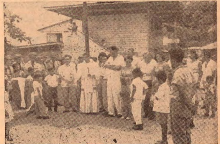
Bendición del puente nuevo, en el pueblo civil de Golfito, obra municipal.
